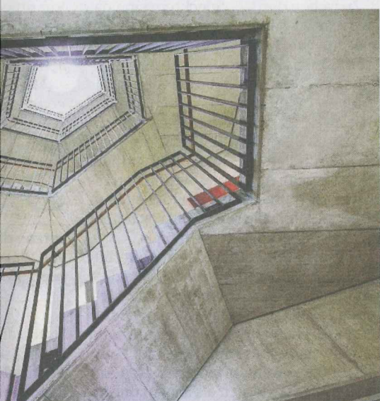
Energie realisiert: Treppenhaus im Neubau.
